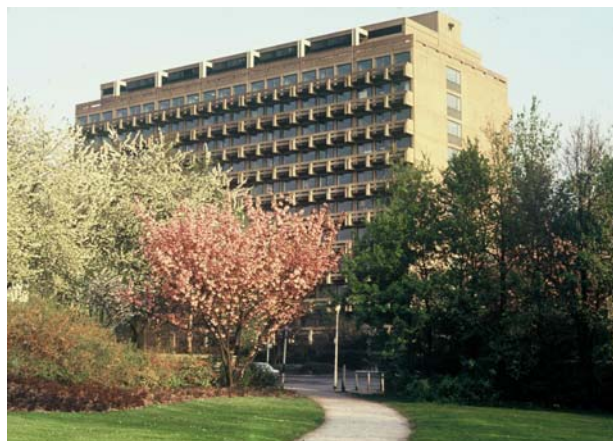
Kaiser-Wilhelm-/Max-Planck-Institut für Kohlenforschung, Mülheim an der Ruhr. Upper: Original laboratory building from 1914, Kaiser-Wilhelm-Platz. Lower: Main laboratory building from 1967, Lembkestraße/Margaretenplatz (Photo: G. Fink, M. W. Haenel, ca. 1988).
